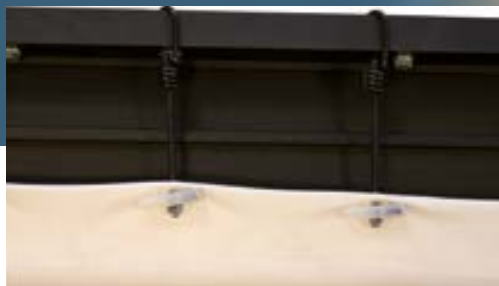
Tension de la toile sur oeilletons à l'arrière du cadre.
